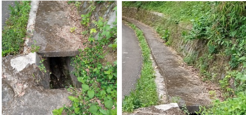
Gambar 2.5. Drainase di Jalan Rambutan
